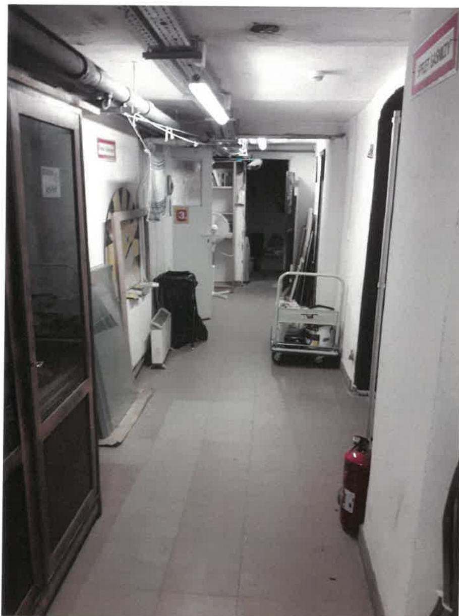
Widok korytarza poz -1
